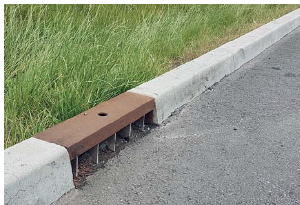
KerbCell i cortenstål med 5 sluser og uden sandfangsbrønd, Klimabyen Middelfart
